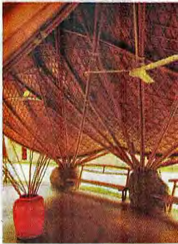
ใช้เทคโนโลยีสมัยใหม่ในการเสียบไม้ไผ่เข้ากับหิน
