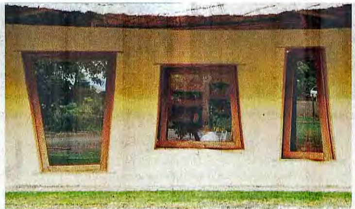
หน้าต่างรูปทรงแปลกตาใช้ด้วยลิ้มไม้ตรงกลางให้พลิกเปิดได้ทั้งสองด้านตามทิศทางลม
