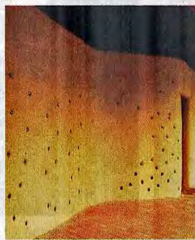
▲ สร้างรูปทรงโค้งมนด้วยการก่ออิฐดิบ ซึ่งทำจากดินและแกลบ
