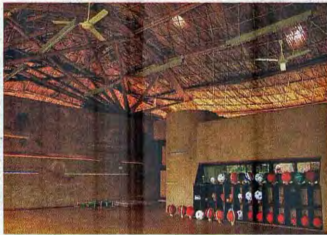
ผนังห้องเรียนใช้ดินอัดซึ่งมีความแข็งแรงและรองรับน้ำหนักได้ดี
