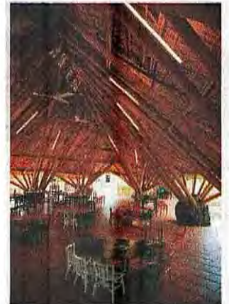
▲ โครงสร้างใช้ไม้ตง อายุ 5-7 ปี ป้องกัน แมลงด้วยการ แช่น้ำยา
